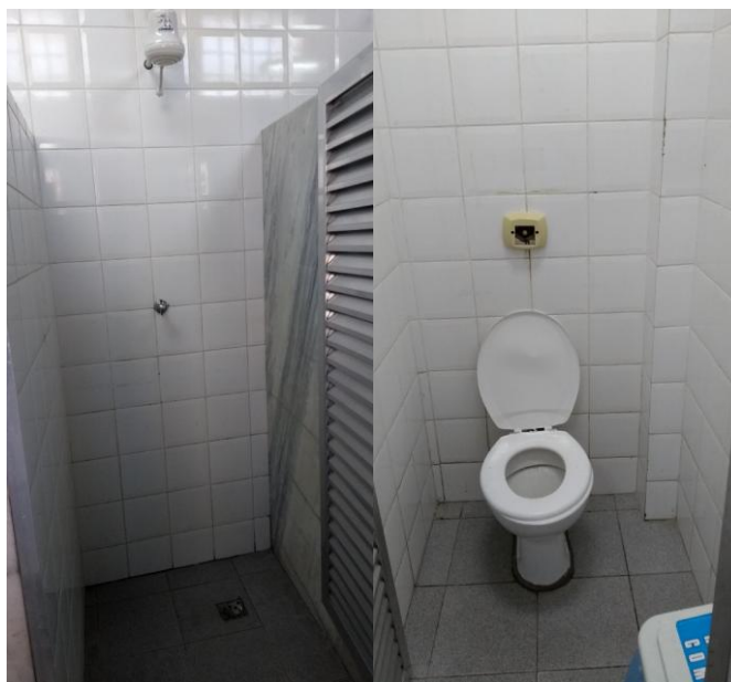
Figuras 3 e 4 – Imagens do banheiro da enfermaria
