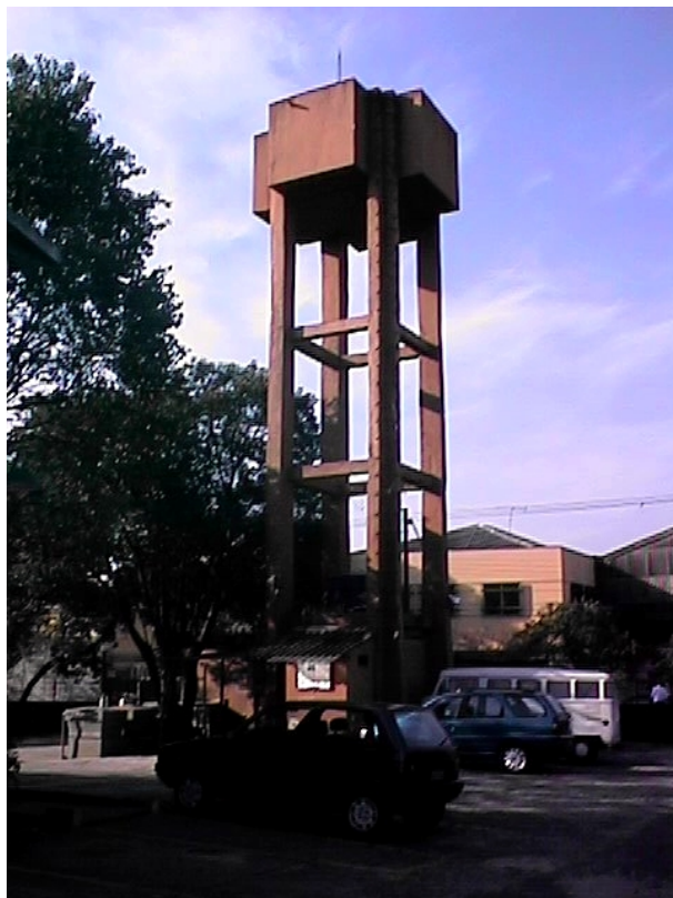
Foto 76- Caixa d'água interdita do Residencial Auriverde próximo da base Shell Carioca. Fonte: CVS/SAMA/GTSolo/eprete
