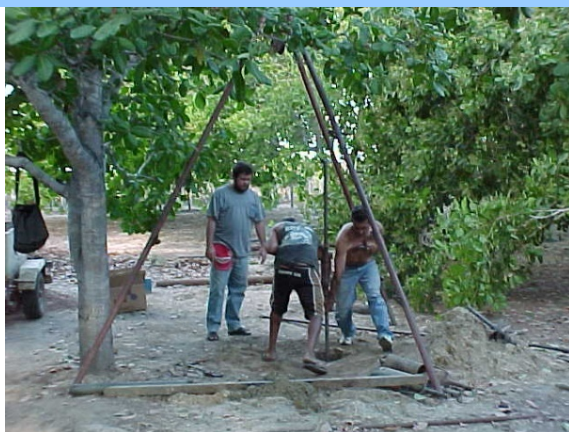
Foto 84- Perfuração de poço raso. Fonte: Arquivo Digital
