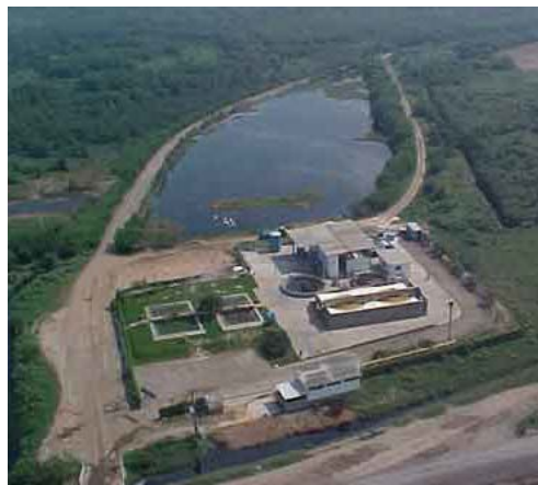
Foto 41- Estação de Tratamento de lixiviados do aterro de Gramacho. Fonte: A Web-Resol
