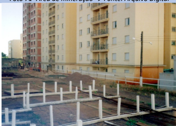
Foto 72- Pátio de obras interditado pela VS de Campinas (Mansões Santo Antônio) → Fonte: CVS/SAMA/GTSolo/epret
