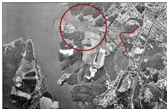
Foto 51- Em 1997, a rápida urbanização causou tal erosão e assoreamento, que o braço da Represa foi aterrado recuando pelo menos um quilometro. O que restou do Ribeirão corre cheio de lixo e esgotos provenientes das casas amontoadas nas encostas.
