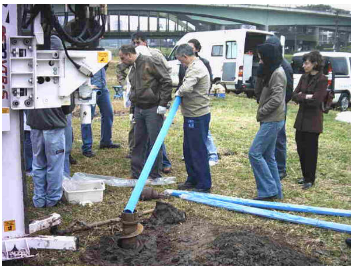
Foto 13- Instalação de Poço de Monitoramento pela CETESB (PM). Fonte: CETESB
