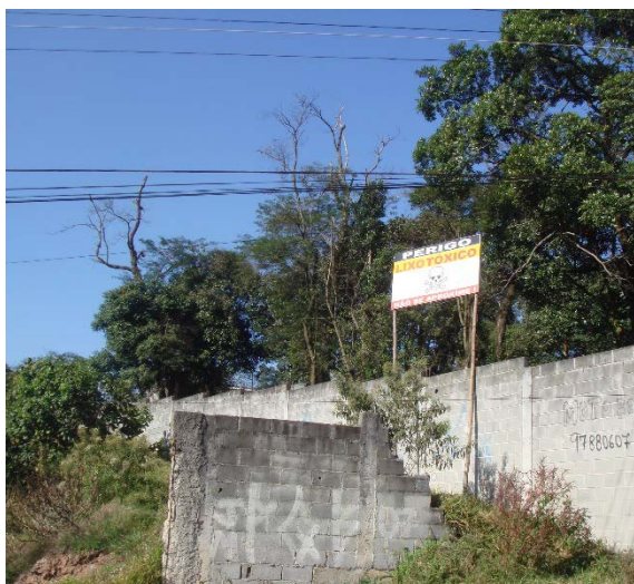
Foto 83- Placa indicando área de risco, mas sem a proteção devida. Fonte: CVS/SAMA/GTSolo/eprete
