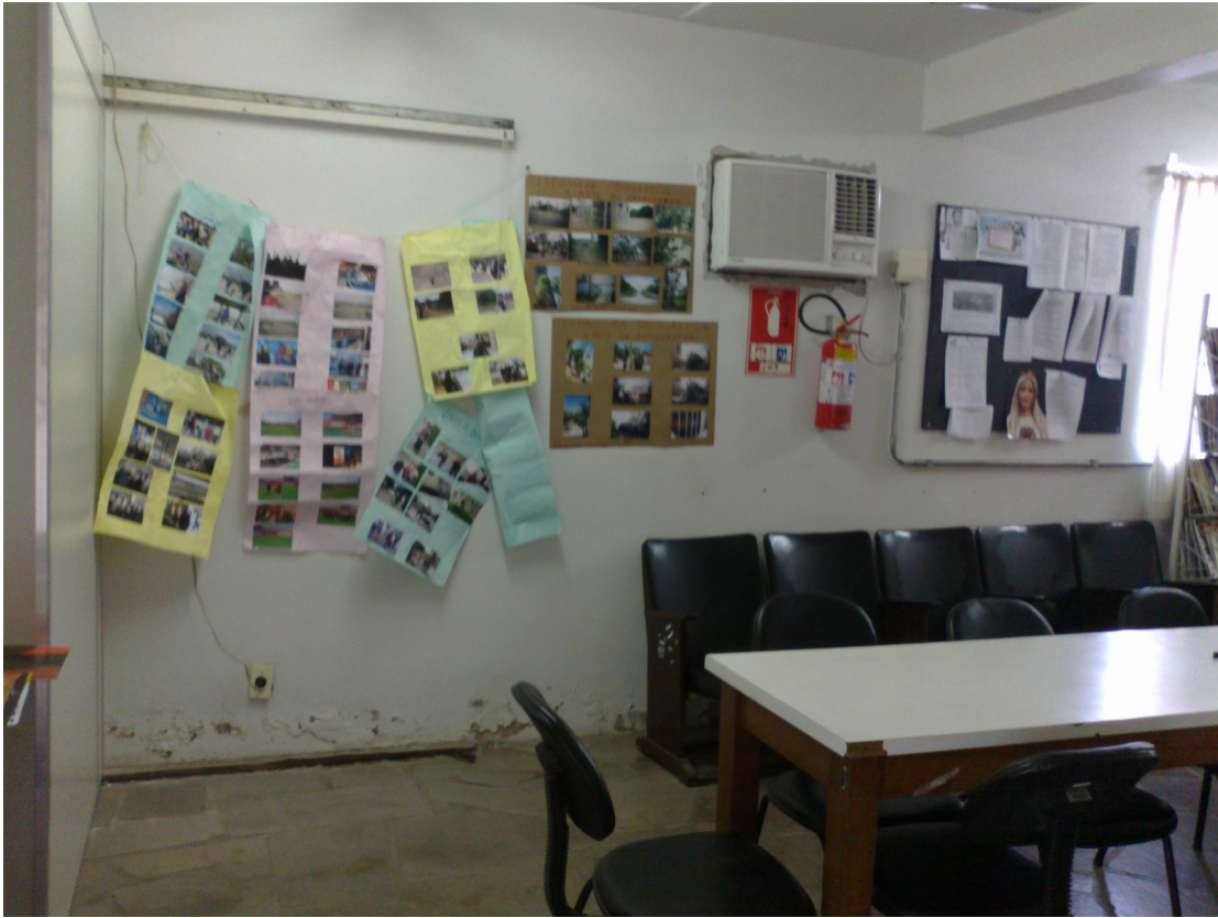
Foto 19 - Cartaz na sala de oficinas
