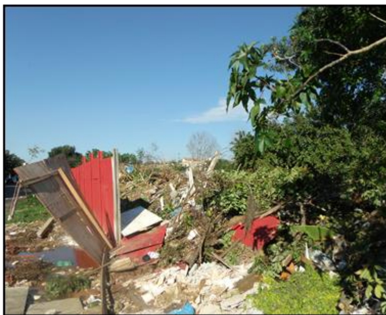
Ilustração 23 – Vila Davi Canabarro e escombros da Carcaça após implosão. Porto Alegre/RS. 2014.
