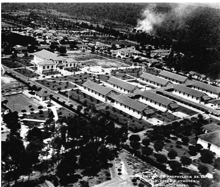
Figura 2. Vista aérea do “Asilo Colônia Aymorés”, em Bauru/SP, evidenciando as unidades de internação (direita) e a quadra esportiva (esquerda).
