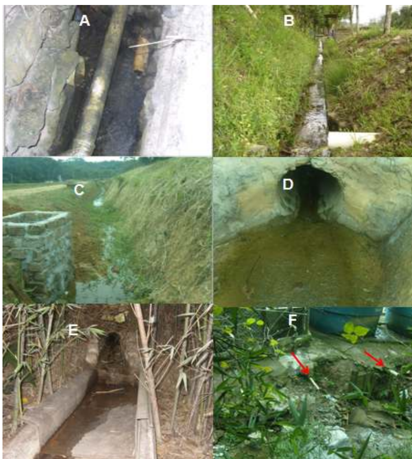
Figura 6: Canaleta - A sistema de escoamento de água na canaleta do Pesqueiro Itapecerica; B - vista geral do ponto de coleta na lateral do lago 3; C – vista da extensão final da canaleta; D – Sistema final de escoamento da canaleta no córrego Valo Velho; E e F- ponto de desague da canaleta no córrego (setas) mostram canos de despejo de esgoto domésticos.
