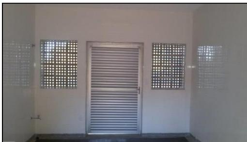
Figura 26 -Telas nas janelas e portas do Abrigo Externo do ILSL para evitar insetos e roedores
