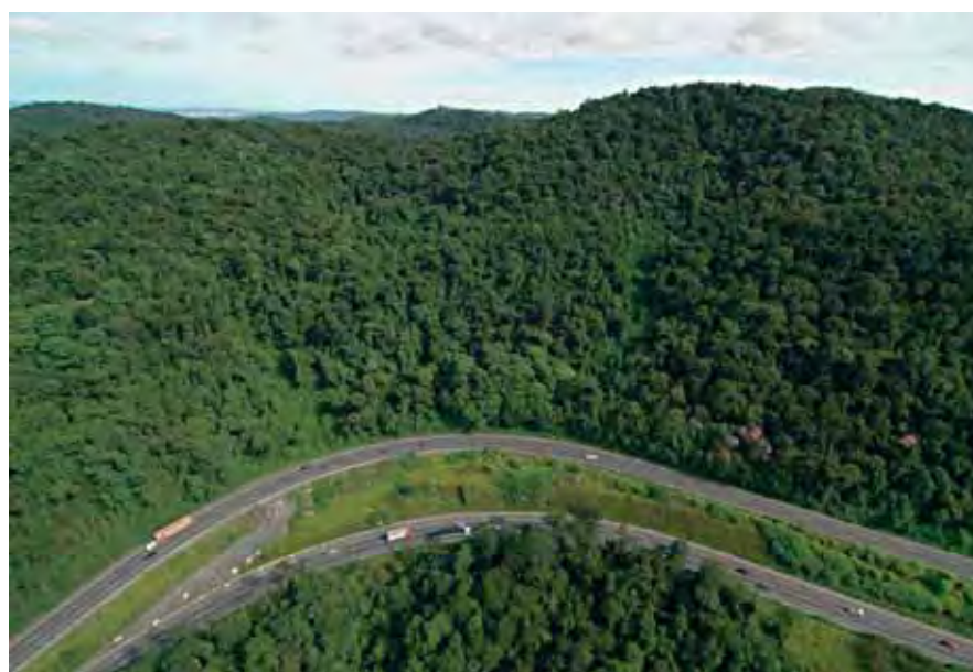
Rodovia Fernão Dias em trecho que atravessa a Serra da Cantareira, em Mairiporã, e remanescentes bem preservados de Mata Atlântica. Foto: latã Cannabrava/ISA (fev/07).
