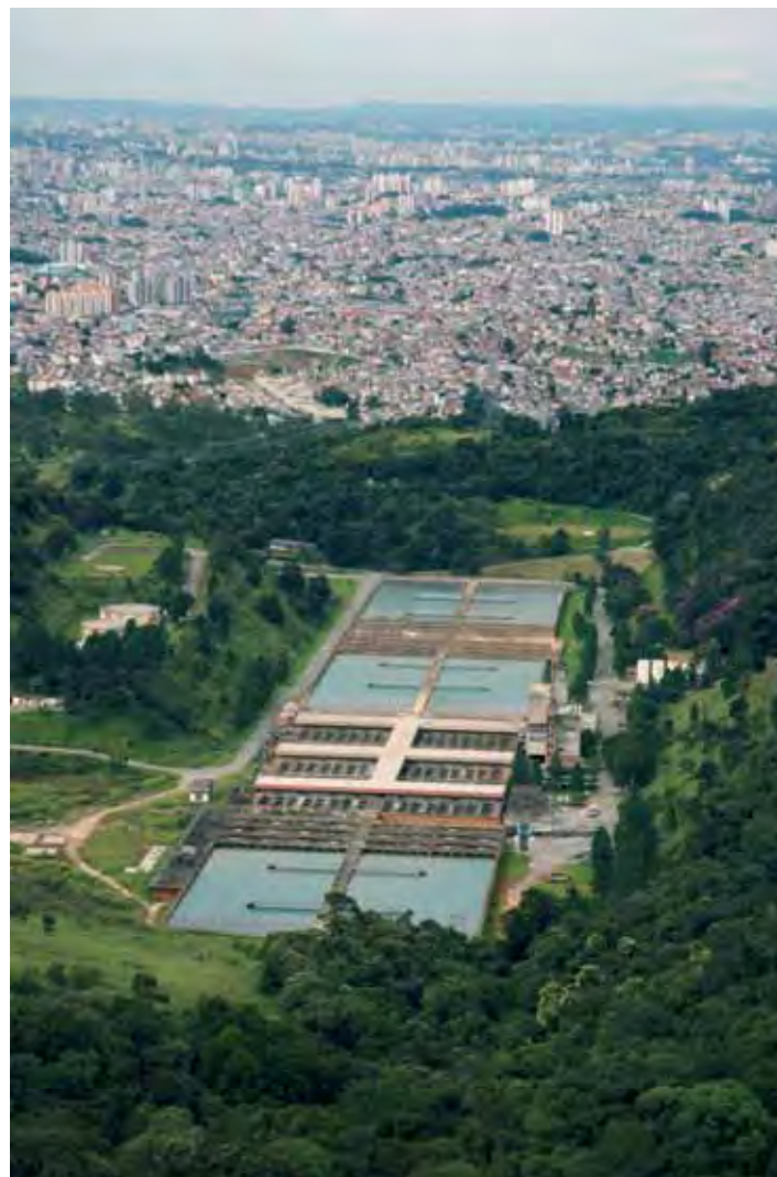
Estação de Tratamento de Água (ETA) do Guarauá, localizada no alto da Serra da Cantareira, e cidade de São Paulo ao fundo. Ali é tratada toda a água proveniente do Sistema Cantareira, que abastece metade da RMSP. Foto: latã Cannabrava/ISA (fev/07).
