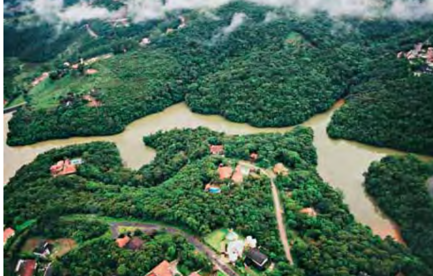
Reservatório de Águas Claras, localizado no alto da Serra da Cantareira, de onde sai a água para a ETA do Guarau. Foto: Rosimeire Rurico Sacó/ISA (fev/04).
