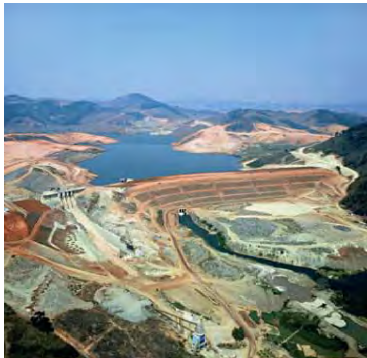
Construção do Reservatório do Rio Jaguari. Foto: Arquivo Sabesp.
