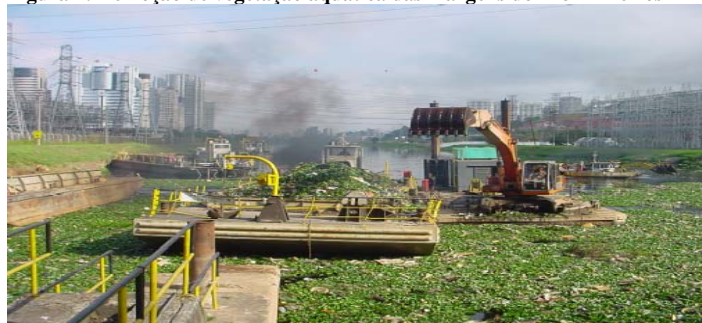
Figura 2: Remoção de vegetação aquática das margens do Rio Pinheiros
