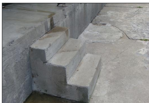
Figura 8: Detalhe da escada de concreto que dá acesso às plataformas.
