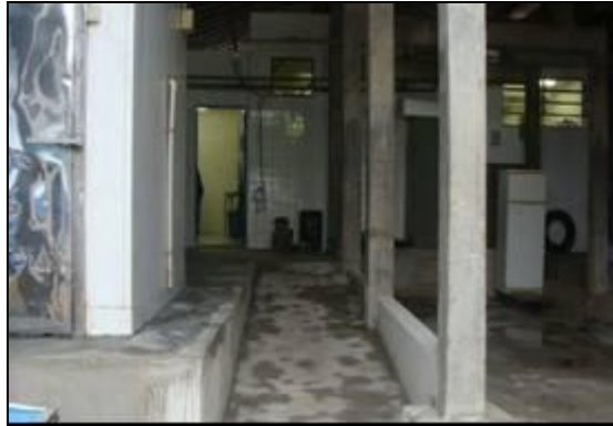
Figura 42: Rampa de acesso à sala de necropsia; à esquerda, a câmara fria.
