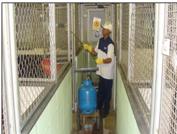
Figura 10: Execução da vassoura de fogo
