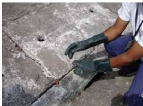
Figura 43. Enrolamento da ponta do arame para facilitar a fixação na boca de lobo.
