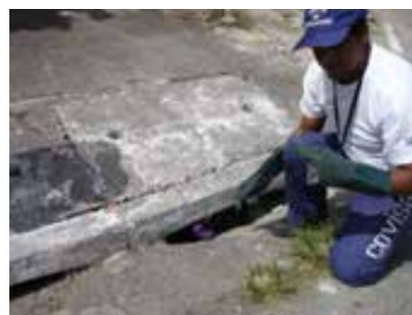
Figura 42. Colocação dos blocos na boca de lobo.
