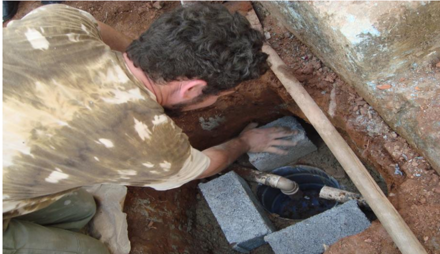
Ilustração da construção da caixa de gordura
