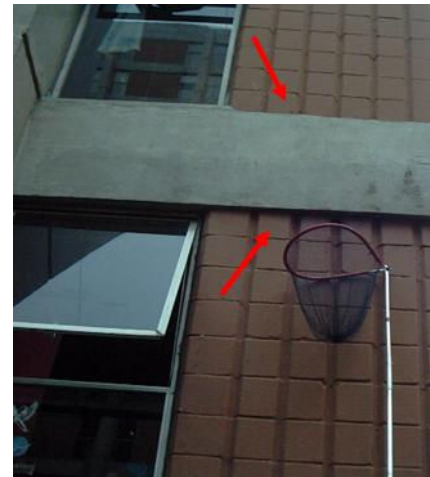
Abrigo em estrutura de prédio Foto: A. Ruckert
