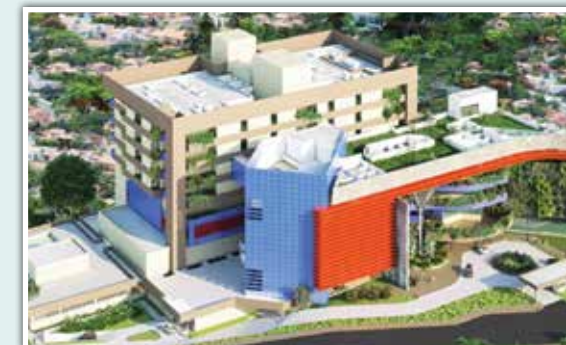
Projeto do Hospital Brasilândia (em obras)
