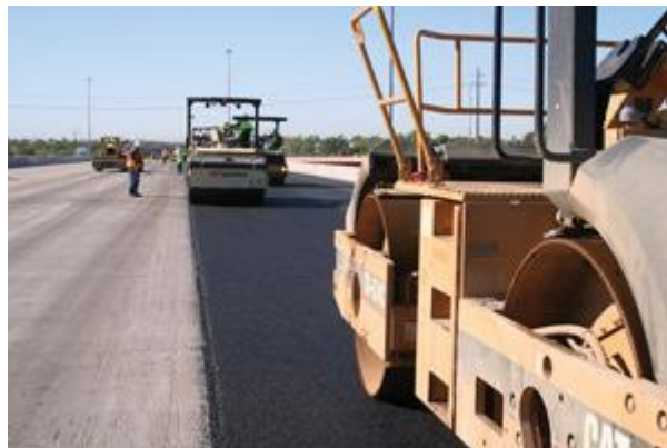
A borracha triturada para misturar com ou asfalto para criar rodovias (scrappygreen.org)
