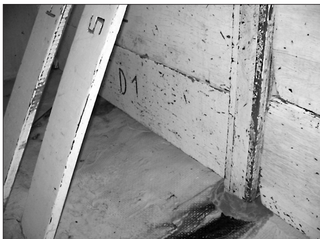
Foto 1. Tablas de madera con astillas y áreas de desgaste en bodegas.
