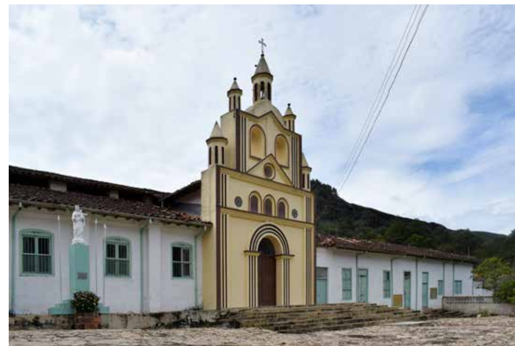
Figura 1.16: Iglesia de Contratación
