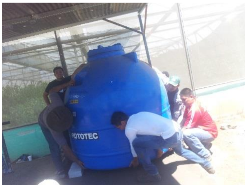
10) Colocación de tanque de 3000lts
