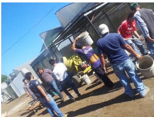
8) Colocación de agregados (Arena y Cemento para elaboración de loza de concreto )
