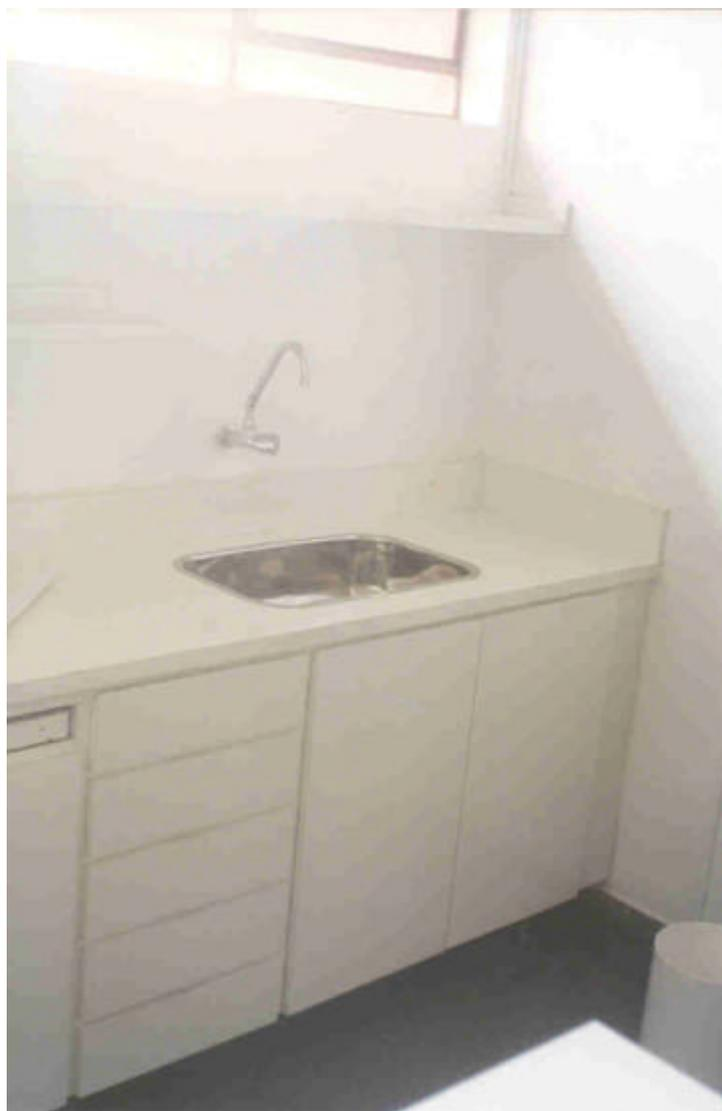
Foto 01 – Parte esquerda da bancada de 2,80m de comprimento, 0,60m de profundidade e 0,90m de altura, onde foi instalado o lavatório. Na parede à direita na foto e acima do lavatório foi instalado o destilador de água.
